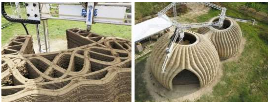
Рисунок 1 – Первый глиняный дом, напечатанный 3D-принтером
